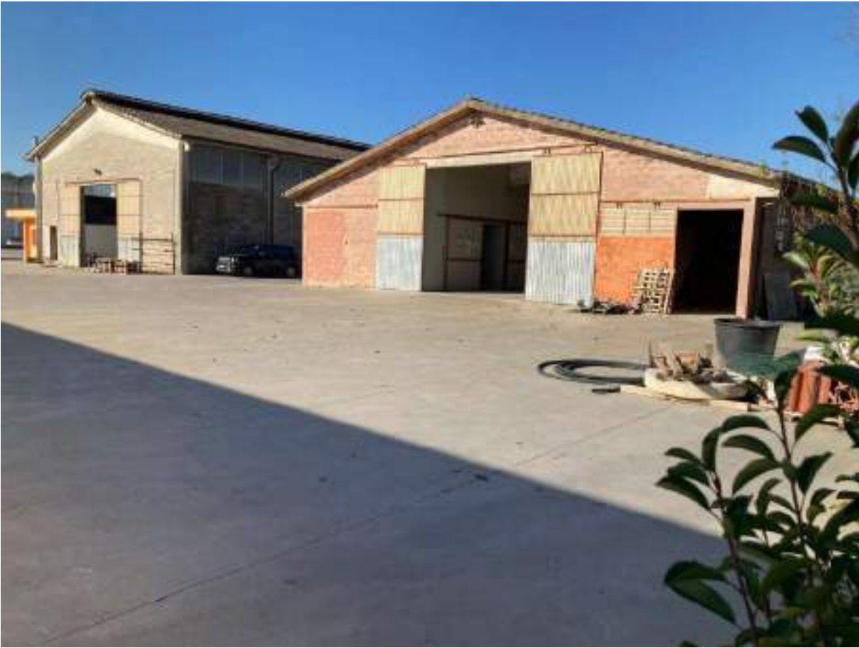
RIPRESA FOTOGRAFICA - In corso di realizzazione - 1
