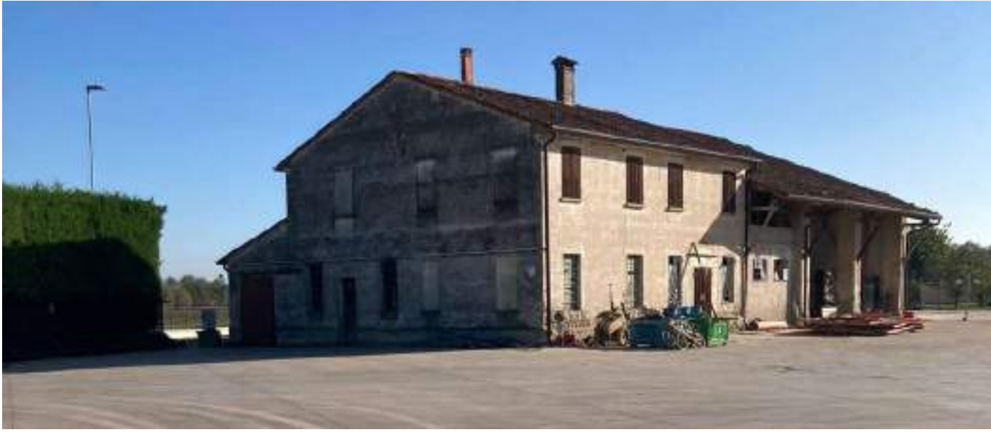
RIPRESA FOTOGRAFICA - In corso di realizzazione - 3
