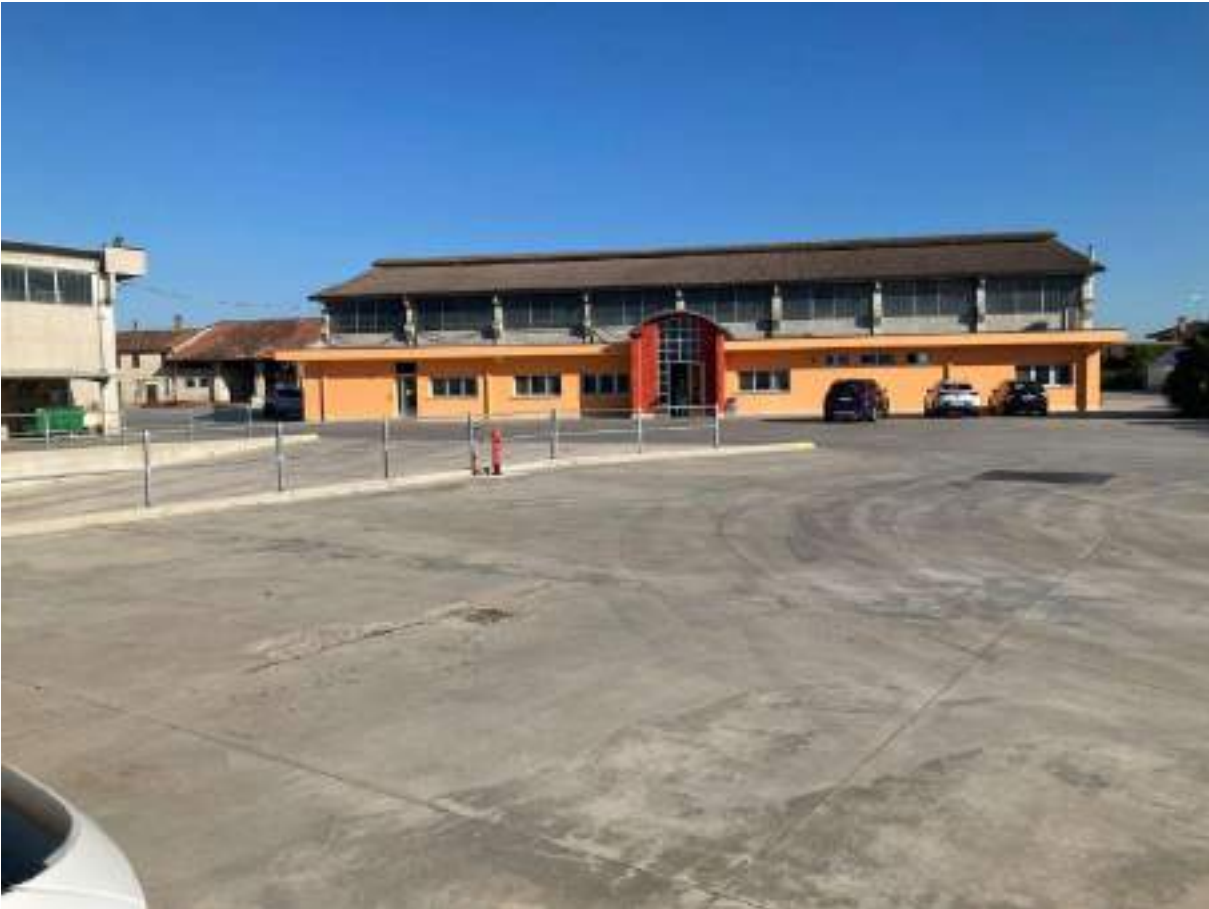
RIPRESA FOTOGRAFICA - In corso di realizzazione - 2
